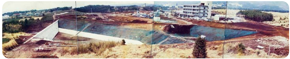
昭和53年 調整池側からの撮影
